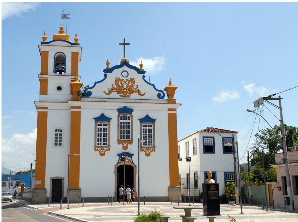
Figura 4: Igreja Nossa Senhora da Piedade, 1º Distrito de Magé, Distrito Sede. Fonte: elaborada pelo autor.
