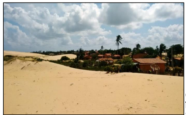
Figura 11: Residência 4, sofrendo influência pelos fundos da residência.
