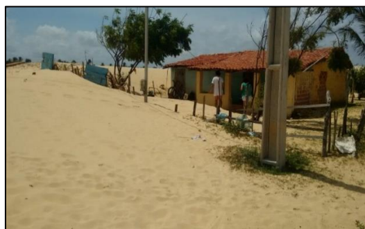
Figura 8: Residência comprometida pelo avanço da Duna Parabólica - Janeiro de 2017
