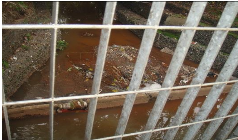
Figura 6: Sistema de telas de gabião nas margens do curso d'água – Fonte: CAU/GO (2013).
