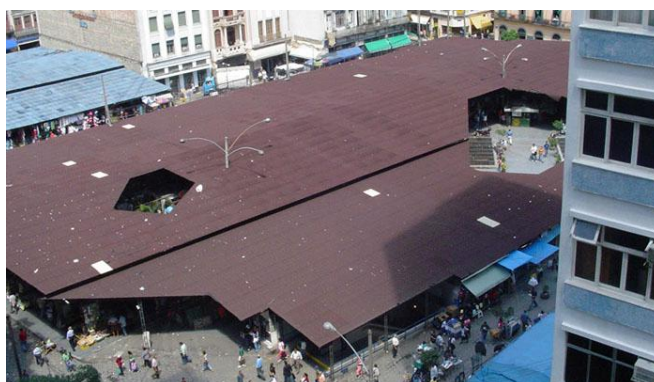
Foto 01: Mercado Popular da Uruguaiana visto de cima Fonte: Estação Uruguaiana - Projeto Final de Graduação - Ludmila Rodrigues http://paginas.terra.com.br/educacao/projeto_uruguaiana/home.html
